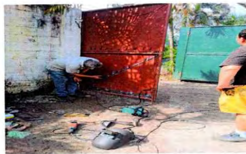
Foto 4: El porton en la parte baja se puede observar que tiene corrosión, por lo mismo se le está dando su mantenimiento.
