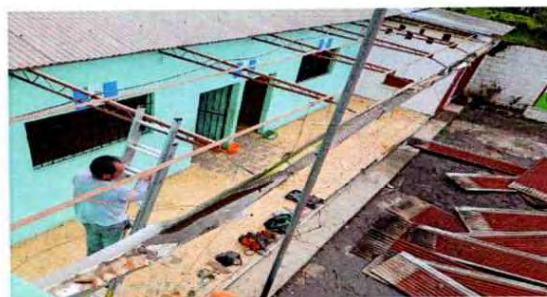
Foto 6: Las láminas se han eliminado por completo de donde se van a sustituir.
