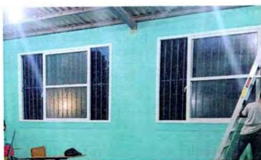
Foto 3: Sustituyendo las ventanas antiguas y ya culminando de instalar ventanas de PVC.
