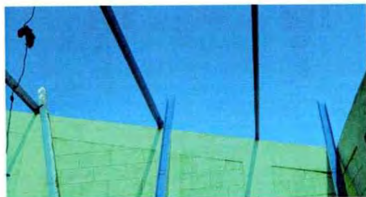
Foto 5: Se observa que se desmonto la estructura de soporte de metal que necesitaba ser sustituida y se está colocando nueva.
