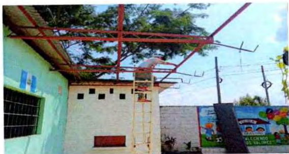
Foto 7: la estructura de metal del corredor necesita mantenimiento y con el cambio de lamina, se está dando su mantenimiento.
