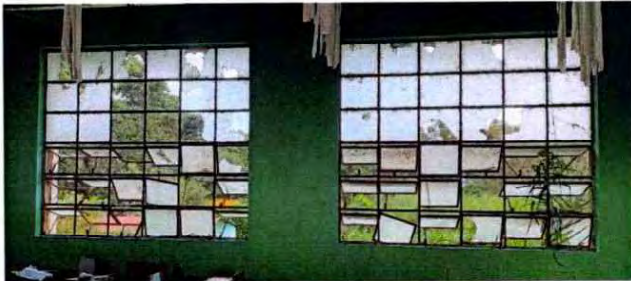
Foto 3: Las ventanas están muy deterioradas, el vidrio por estar quebrado tiende a caerse en cualquier momento y es un riesgo para los estudiantes, por lo que es necesario su sustitución.
