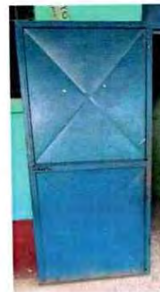
Foto 12: Las puertas ya presentan daño en pintura y presentan oxido, por lo que se requiere su mantenimiento.
