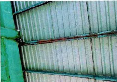
Foto 5: La estructura del techo de las escaleras, se encuentra bastante deteriorada (carcomido por el oxido), por lo que es necesario su sustitución.
