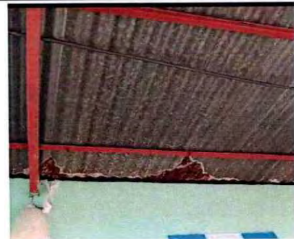
Foto 6: Las láminas se observan oxidadas y deterioradas por lo mismo se deben de sustituir.
