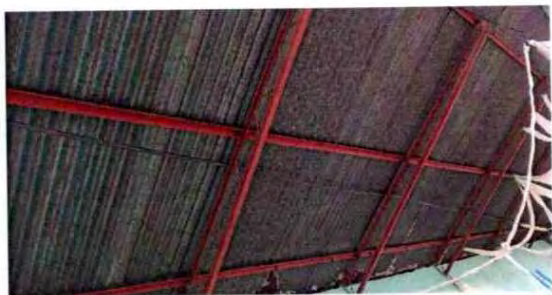
Foto 7: la estructura de metal del corredor necesita mantenimiento y con el cambio de lamina se aprovechará en hacerlo.
