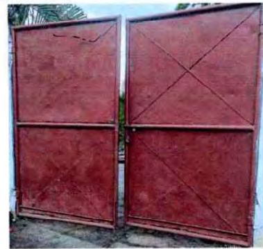
Foto 4: El portón en la parte baja se puede observar que tiene corrosión, se requiere su reparación.
