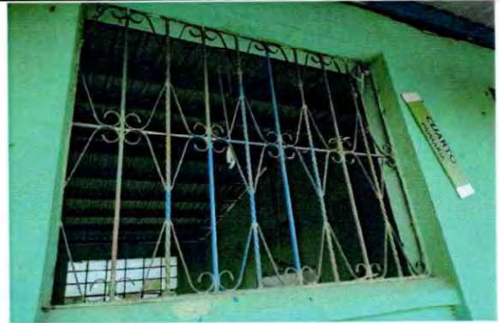
Foto 2: Los balcones presentan deterioro en la pintura y es necesario darle su mantenimiento.
