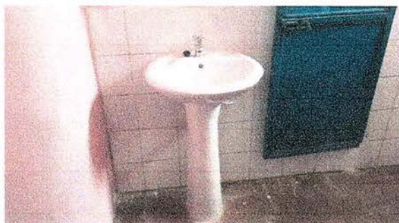
Foto 5: Sustitucion de dos lavamanos viejos por dos nuevos.
