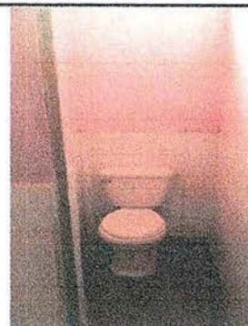
Foto 4: Cambio de cuatro servicios sanitarios.
