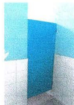
Foto 6: Se colocaron puertas nuevas en los servicios sanitarios de niños.
