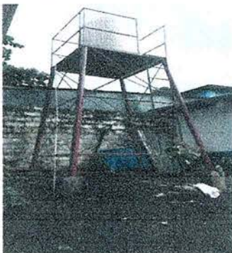
Foto1: Suministro de torre y deposito de agua de 1100 litros.
