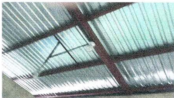
Foto1: Mantenimiento completo a estructura metalica.
