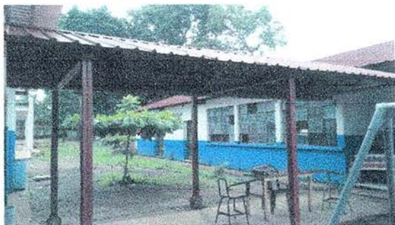
Foto 1: Se completo mantenimiento de estructura metalica y techo del pasillo.
