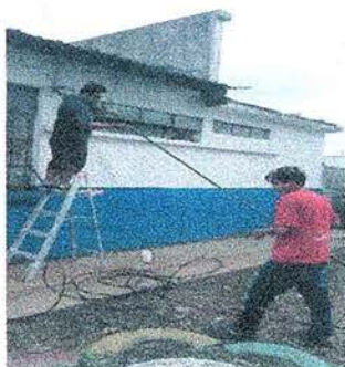
Foto 3: Colocando el nuevo sistema electrico.
