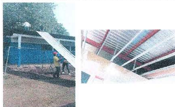
Foto 2: Quitando la lamina dañada colocando estructura de aluminio para cielo de pvc.
