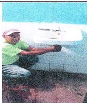
Foto 5: Quitando el lavamanos dañado.
