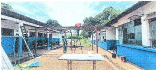
Foto1: Mantenimiento a estructura metalica y techo del pasillo.
