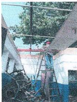
Foto1: Se observa que se le esta dando mantenimiento a la estructura
