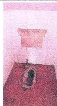
Foto 4: Se quitaron los sevicios sanitarios dañados.
