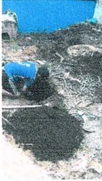
Foto1: Realizando trabajo para la fundición de las bases de torre para el depósito de agua.
