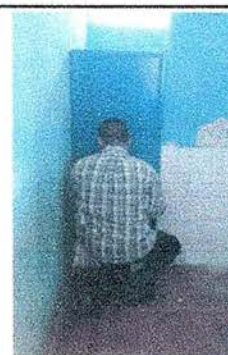
Foto 6: Realizacion de puerta para los baños.
