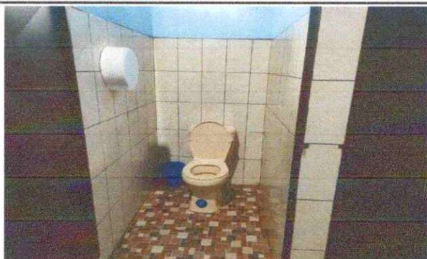
Foto 3: En esta fotografía se observa la finalización de la sustitución de los sanitarios en los módulos de hombres y mujeres
