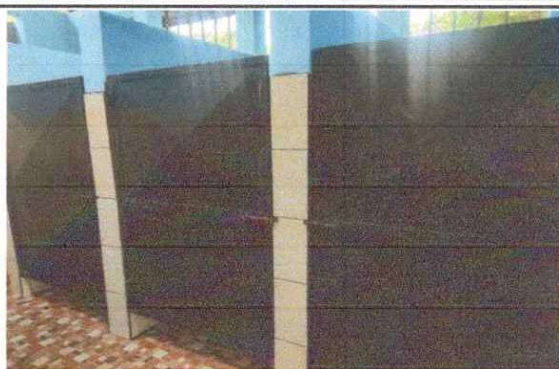
Foto 8: En esta fotografía se observa que se han sustituido todas las puertas de madera por puertas de metal en todos los servicios sanitarios de los módulos
