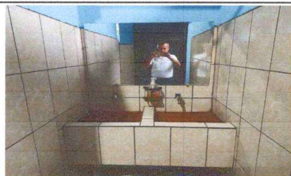
Foto 4: En esta fotografía se observa la finalización del remozamiento del servicio de lavamanos de concreto y azulejo en los servicios sanitarios en los módulos de hombres y mujeres
