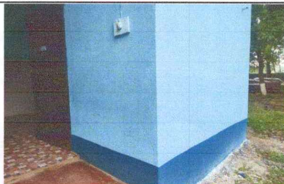
Foto 2: En esta fotografía se observan le resultado de las mejoras de imperfecciones y aplicación de pintura
