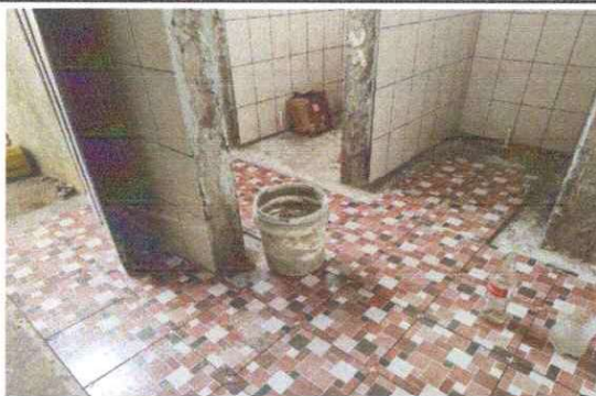
Foto 3: En esta fotografía se observan los avances para la sustitución de los sanitarios en los módulos de hombres y mujeres
