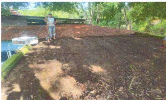
Foto 9: En esta fotografía se observa que se inicia con los trabajos de remozamiento de la loza
