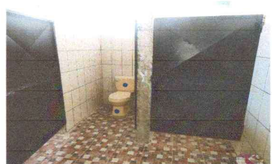
Foto 8: Se sustituyen las puertas de madera por puertas de metal en todos los servicios sanitarios de los módulos
