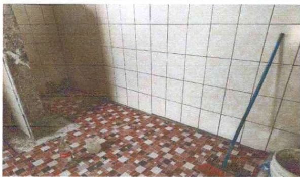
Foto 1: En esta fotografía se observa que la sustitución del piso cerámico se está realizando en los módulos de los servicios sanitarios de hombres como de mujeres
