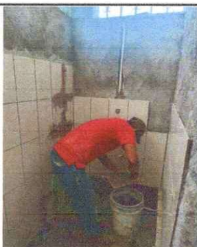
Foto 5: En esta fotografía se observan los avances en el remozamiento completo de la ducha en los módulos sanitarios de hombres y mujeres
