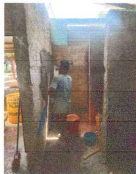
Foto 2: En esta fotografía se observan las mejoras en imperfecciones para luego aplicar pintura
