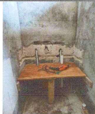
Foto 4: En esta fotografía se observa el inicio del remozamiento de los lavamanos en los módulos de los servicios sanitarios de hombres y mujeres
