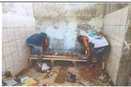
Foto 6: En esta fotografía se observa que se inicia el remozamiento del mingitorio en el módulo de servicios sanitarios de hombres
