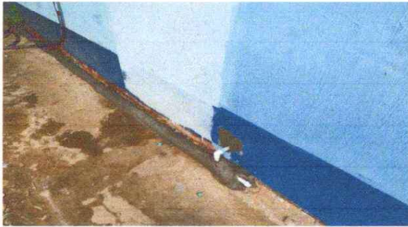
Foto 7: En esta fotografía se observa que se inicia con el trabajo de ocultar la línea principal de agua, para proteger la tubería de daños provocados por los estudiantes
