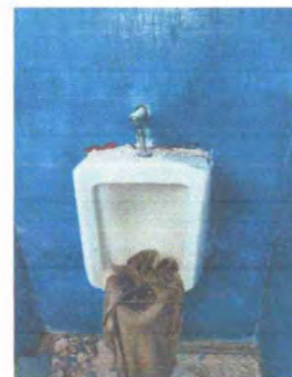
Foto 6: Los migitorios se encuentran en mal estado y por ahorrar espacio se sustituirán por unos de concreto y azulejo
