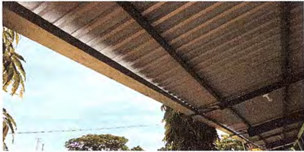
Foto 11: SE OBSERVA QUE EL CANAL DE METAL DEL MÓDULO 2 FUE SUSTITUIDO.
