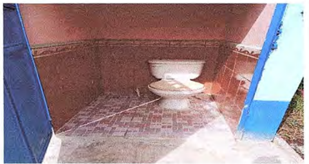
Foto 4: SE OBSERVA QUE EL PISO YA FUE SUSTITUIDO Y MUROS CON AZULEJO
