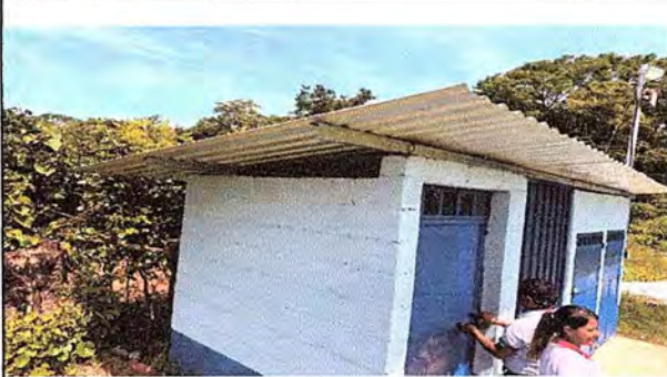
Foto1: SE OBSERVA QUE SE SUSTITUYO LÁMINA Y ESTRUCTURA DE SOPORTE DE METAL DEL SERVICIOS DE SANITARIOS.
