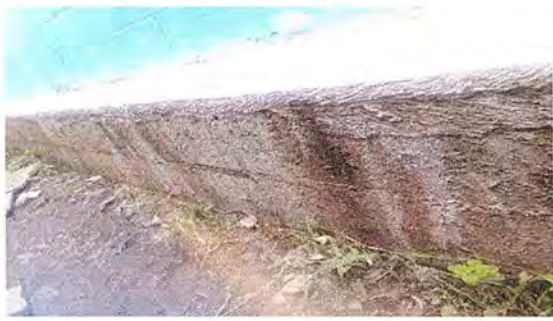
Foto 10: SE OBSERVA QUE LA BANQUETA DEL MÓDULO 2, ESTA SIENDO REPARADA.
