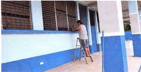
Foto 12: SE OBSERVA QUE BALCONES DE METAL DEL MÓDULO DE AULAS 2 ESTA RECIBIENDO MANTENIMIENTO PREVENTIVO.
