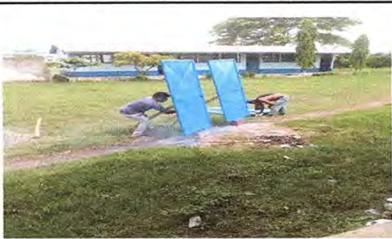
Foto 13: SE OBSERVAN QUE LAS PUERTAS DEL MÓDULO DE AULAS ESTAN RECIBIENDO SU MANTENIMIENTO PREVENTIVO.
