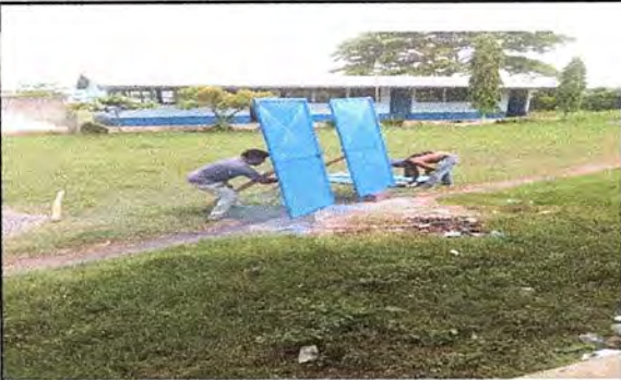
Foto 7: SE OBSERVAN QUE LAS PUERTAS DEL MÓDULO DE SERVICIOS SANITARIOS LES ESTAN DANDO SU MANTENIMIENTO PREVENTIVO.
