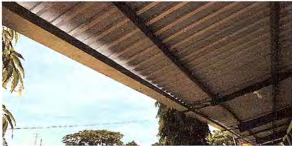
Foto 11: SE OBSERVA QUE ESTAN INSTALANDO EL CANAL DE METAL DEL MÓDULO 2,
