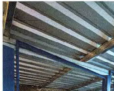
Foto 6: Finalización de la estructura metálica.
