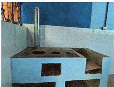
Foto 1: Finalización de la estufa.
