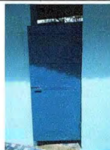
Foto 10: Finalización de las puertas de los baños.
