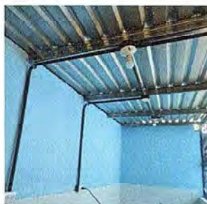
Foto 5: Finalización de instalación eléctrica.
