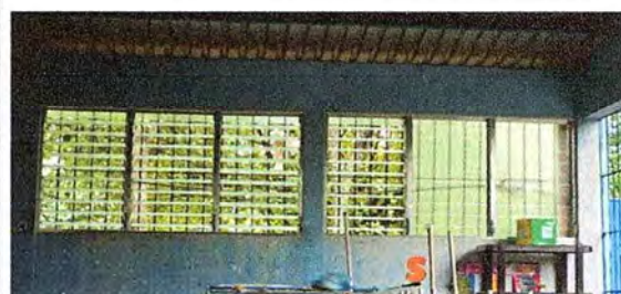
Foto 16: Finalización de la instalación de ventanería
