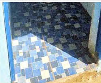
Foto 12: Finalización de la colocación de piso antideslizante.
