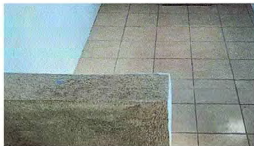
Foto 2: Finalización del piso de la cocina.
