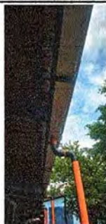
Foto 19: Finalización del cambio de canales de agua pluvial
