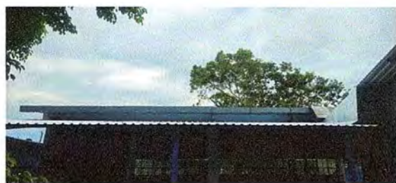
Foto 15: Finalización de la reparación del canal.
