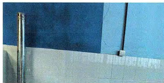
Foto 9: Finalización del repello de la pared.
