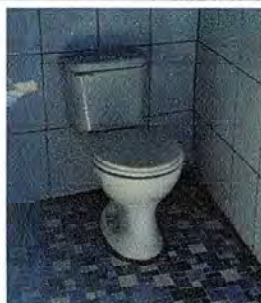
Foto 11: Finalización del cambio de inodoros.
