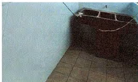
Foto 3: Finalización de colocación de azulejo en la cocina.
