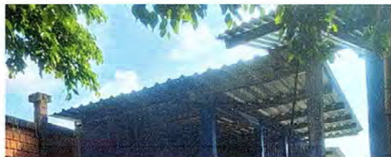
Foto 7: Finalización del cambio de lámina.
