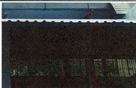
Foto 17: Finalización del cambio de lámina.
