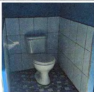
Foto 13: Finalización de azulejo en las paredes.
