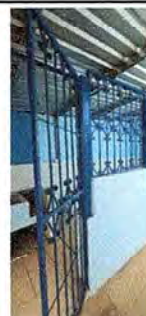
Foto 8: Finalización de los balcones.
