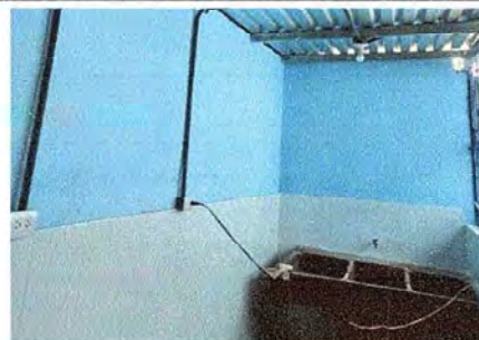
Foto 4: Finalización de la pared de la cocina pintada.
