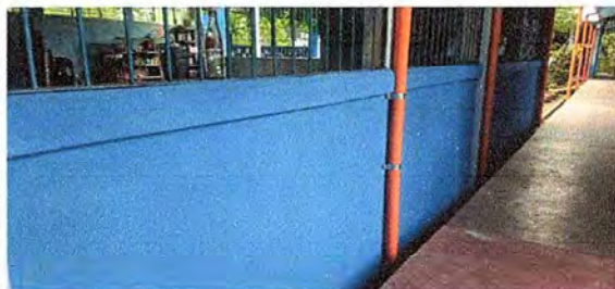
Foto 20: Finalización de la pintura de las paredes.
