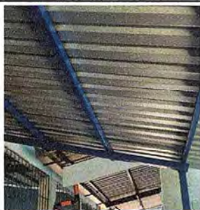
Foto 17: En proceso el cambio de lámina.
