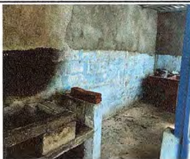
Foto 3: Se observa la pared en trabajo de remozamiento para colocar azulejo.
