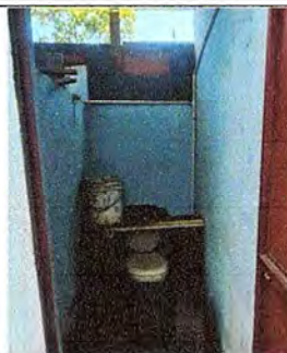
Foto 14: En proceso la reparación del muro.
