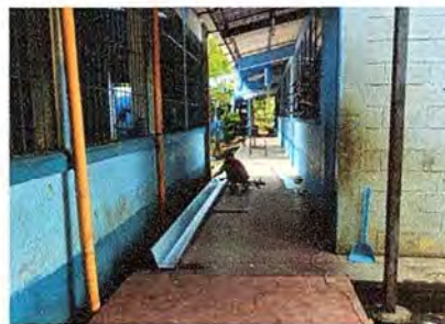
Foto 20: En proceso la pintura de las paredes.
