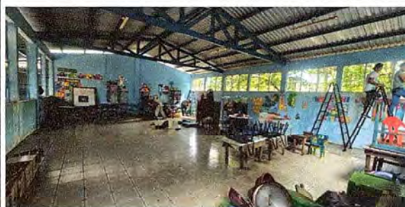
Foto 16: En proceso la instalación de ventanería
