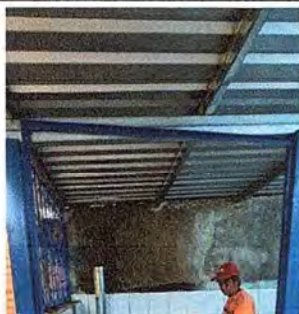
Foto 7: En proceso el cambio de lámina.
