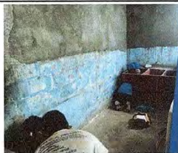
Foto 4: Se observa en proceso la limpieza de la pared para posteriormente pintarla.
