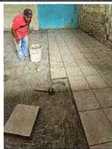
Foto 18: En proceso la instalación de piso cerámico.
