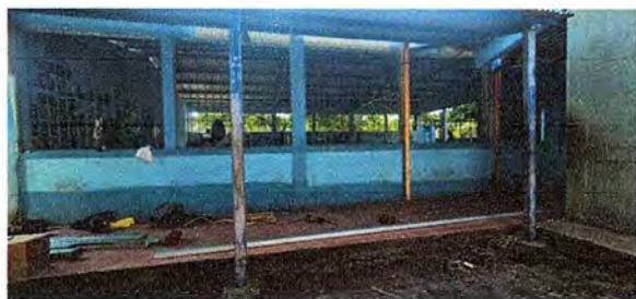
Foto 15: En proceso la reparación del canal.
