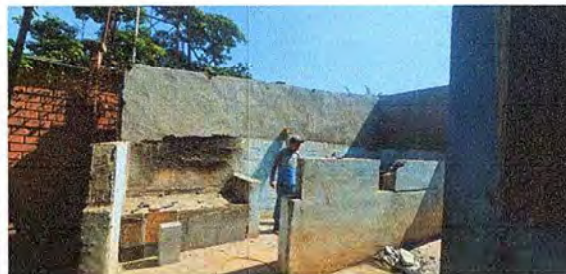
Foto 2: En proceso el remozamiento del piso de la cocina.
