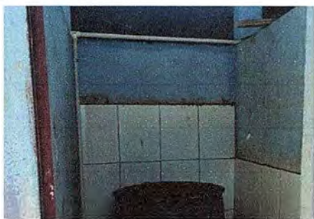
Foto 13: En proceso la colocación de azulejo en las paredes.
