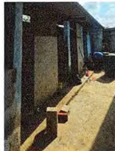
Foto 10: Se observa en proceso el mantenimiento de las puertas de los baños.
