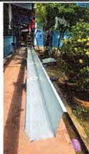
Foto 19: En proceso el cambio de canales de agua pluvial
