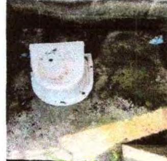
Foto 6. Se observa que el servicio sanitario ya no está en condiciones adecuadas y el piso necesita la sustitución a piso cerámico ya que no es higiénico el que se observa.
