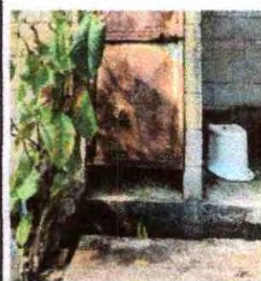
Foto 6. Se observa que el servicio sanitario ya no está en condiciones adecuadas y el piso necesita la sustitución a piso cerámico ya que no es higiénico el que se observa.
