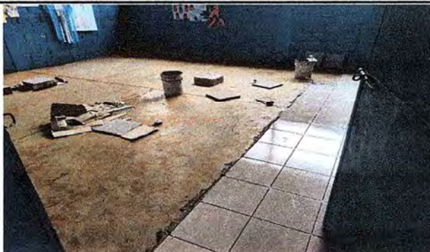
Foto 7: SE OBSERVA EL PROCESO DE INSTALACIÓN DE PISO CERÁMICO.
