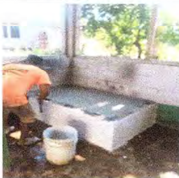
Foto 5: SE OBSERVA EL PROCESO DE CONSTRUCCIÓN DE ESTUFA ARTESANAL.
