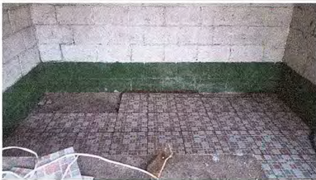
Foto 3: SE OBSERVA EL PROCESO DE LA INSTALACIÓN DEL PISO CERÁMICO ANTIDESLIZANTE.
