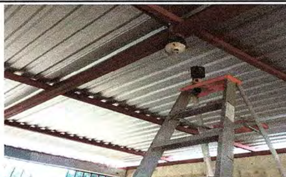
Foto 8: SE OBSERVA LA SUSTITUCIÓN DEL SISTEMA ELÉCTRICO.
