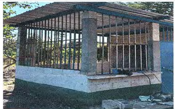
Foto 4: SE OBSERVA LA INSTALACIÓN DE BALCONES.
