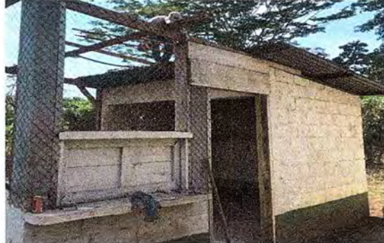
Foto 6: SE OBSERVA EL PROCESO DE SUSTITUCIÓN DE PUERTA.
