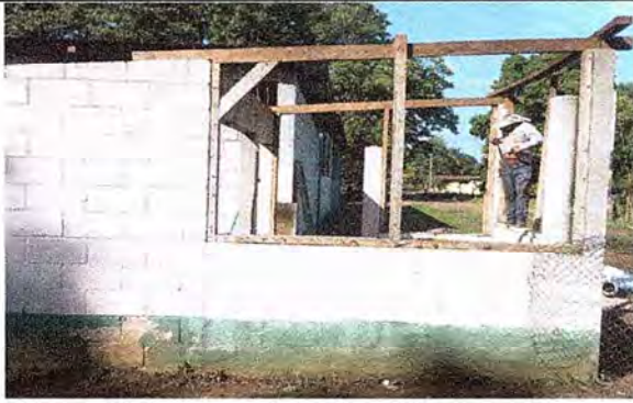
Foto 1: SE OBSERVA EL PROCESO DE CAMBIO DE ESTRUCTURA DE MADERA POR METAL.
