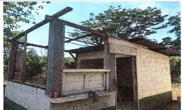
Foto 2: SE OBSERVA EL PROCESO DE CAMBIO DE LÁMINA.
