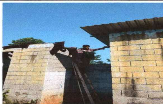
Foto 2: Se Observa que el baño esta con lamina nueva y costanera esta haciendo colocada
