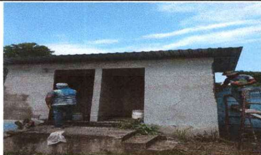
Foto 1. Se observa que la estructura de baño esta haciendo trabajada
