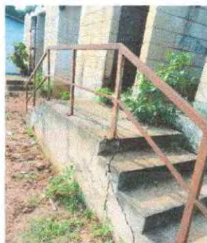
Foto 8. Se observa el deterioro de los barandales por lo cual se necesita cambio
