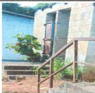
Foto 3. Se observa el daño por oxidación de las puertas de los baños por lo que se necesita cambio de puertas
