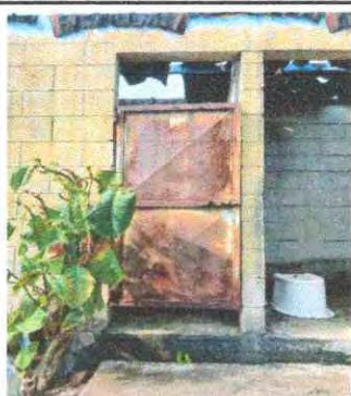
Foto 3. Se observa el daño por oxidación de las puertas de los baños por lo que se necesita cambio de puertas
