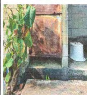
Foto 6. Se observa que el servicio sanitario ya no está en condiciones adecuadas y el piso necesita la sustitución a piso cerámico ya que no es higiénico el que se observa.
