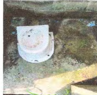
Foto 6. Se observa que el servicio sanitario ya no está en condiciones adecuadas y el piso necesita la sustitución a piso cerámico ya que no es higiénico el que se observa.
