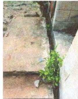
Foto 10. Se observan la necesidad de reparación de las torta de cemento
