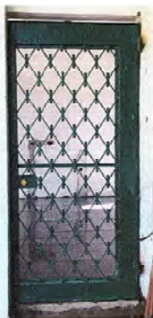
Foto 3: Se observa la puerta colocada de la cocina.
