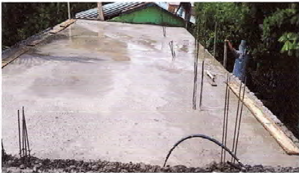
Foto 1: Se observa la losa construida de la cocina.
