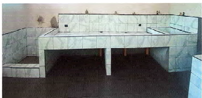
Foto 9: Se observa la pila de cocina terminada.
