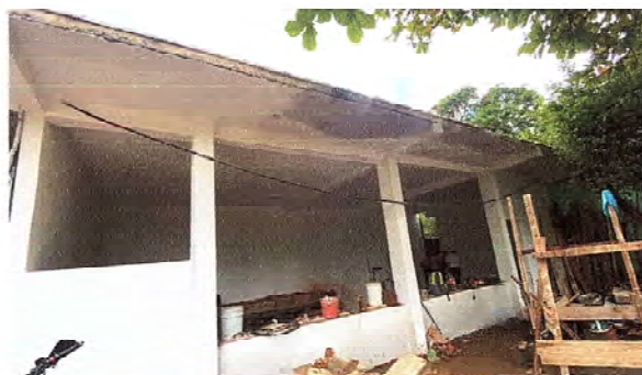
Foto 10: Se observa el área repellada y cernida de la fachada de la cocina.
