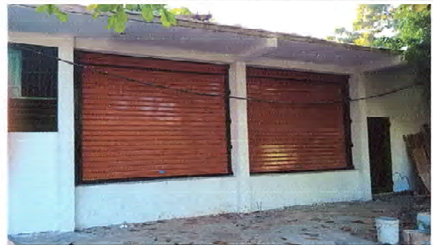
Foto 4: Se observan los valcones y cortinas instaladas.
