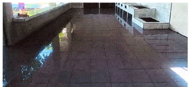
Foto 6: Se observa Instalado el piso de cocina.
