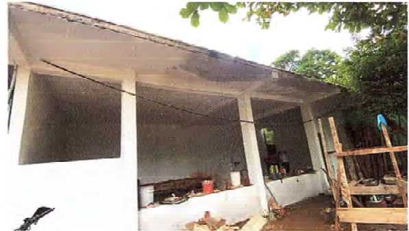
Foto 2: Se observa la losa construida de la cocina.
