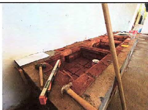
Foto 5: Se observa el proceso de construcción de los polletones.
