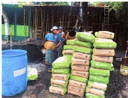
Foto 1: Se observa proceso de fundición de losa.
