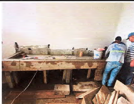
Foto 9: Se observa el proceso de construcción de pila.
