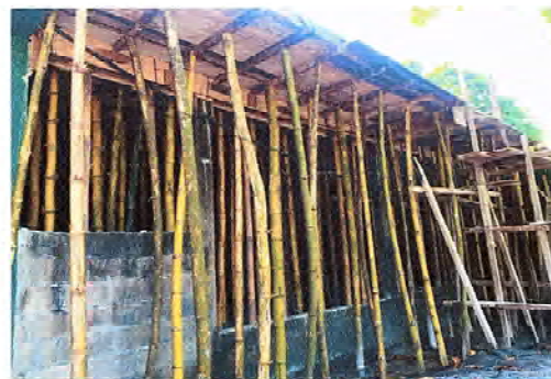
Foto 2: Se observa el entarimado de la losa.
