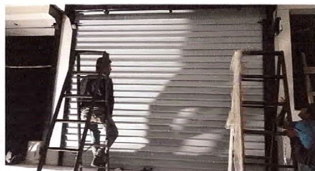
Foto 4: Se observa el proceso de instalación de cortinas.
