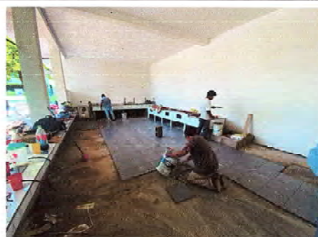
Foto 6: Se observa la colocación del piso de cocina.
