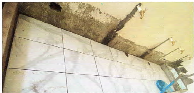
Foto 7: Se observa el espacio donde se están colocando los grifos de agua.
