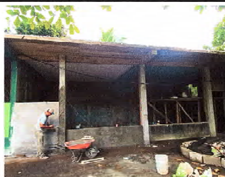
Foto 10: Se observa el proceso de aplicación de repello más cernido, por dentro y por fuera.
