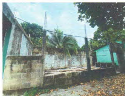
Foto 10: Se observa el área donde debe aplicarse el repello más cernido, por dentro y por fuera.
