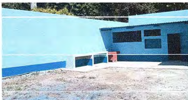
Foto 9: Se observa que se reparó el muro perimetral.
