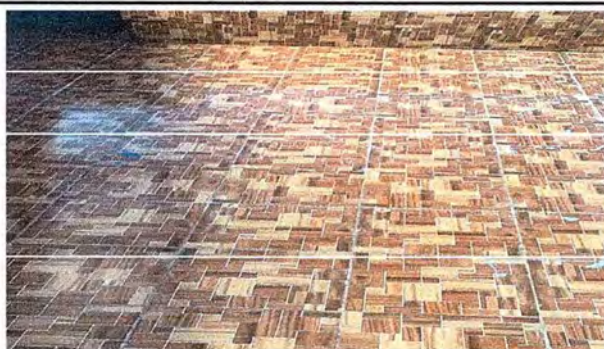
Foto 5: Se observa que se realizó la sustitución de torta de concreto por piso cerámico.
