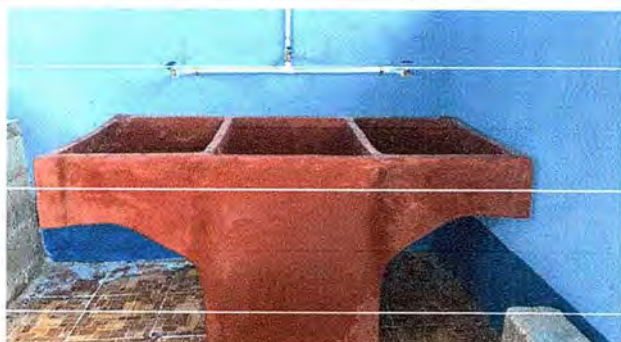
Foto 13: Se observa que se sustituyó la pila.
