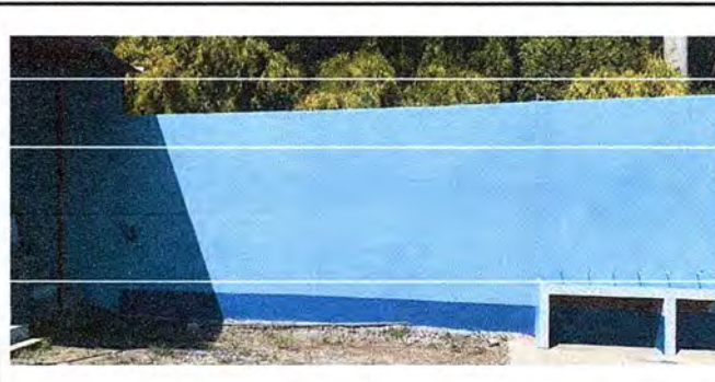
Foto 6: Se observa que se aplicó pintura latex acrílica en muros exteriores e interiores.
