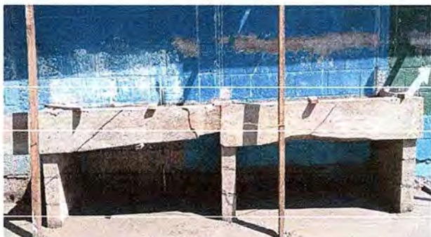
Foto 7: Se observa que se está realizando una estación de lavado.
