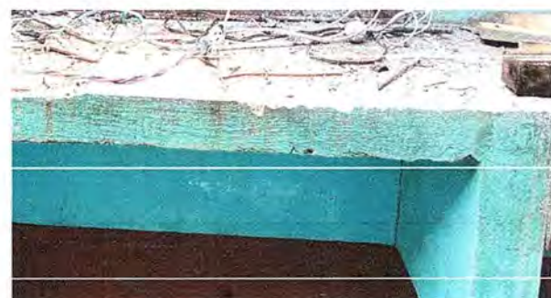
Foto 12: Se observa que se están reparando los azulejos en mueble de cocina
