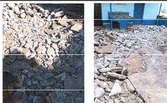
Foto 10: Se observa que se está reparando la plancha de concreto en patio.
