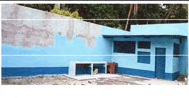
Foto 6: Se observa que se está aplicando pintura latex acrílica en muros exteriores e interiores.
