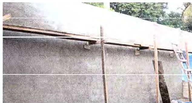
Foto 14: Se observa que se está repellando el muro y sellando las grietas y fisuras.
