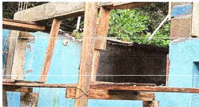
Foto 4: Se observa el proceso para sustituir balcones de metal.
