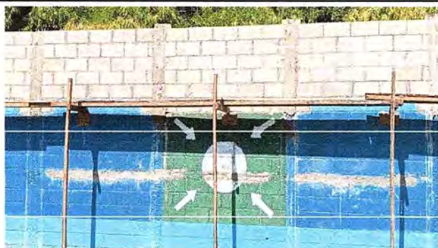
Foto 9: Se observa que se está reparando el muro perimetral.
