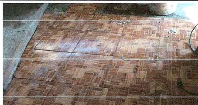
Foto 5: Se observa que se está sustituyendo torta de concreto por piso cerámico.
