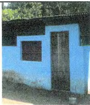
Foto 3: Se observa que se necesita urgentemente sustitución de puertas
