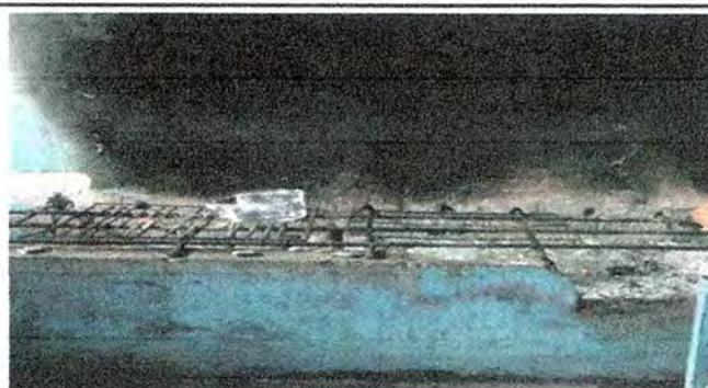
Foto 11: Se observa que la estufa rural necesita reparación.
