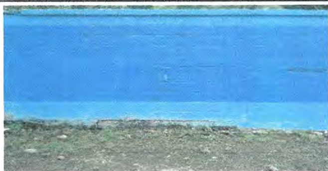
Foto 7: Se observa que no existe estación de lavado y es necesario la instalación para una buena higiene.
