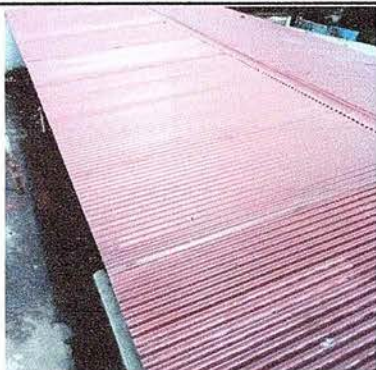
Foto 1: Se observa la finalización de cambio de la lámina.
