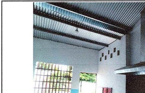
Foto 9 : Se observa la finalización de cambio de la estructura a metal.
