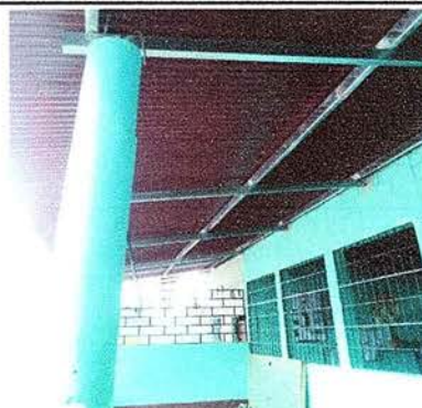
Foto 2: Se observa la finalización de cambio de la estructura de madera a metal.
