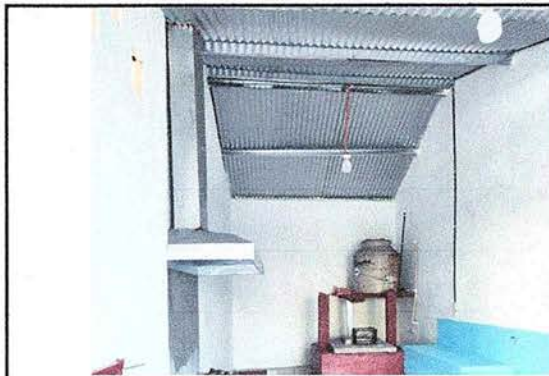
Foto 8 : Se observa la finalización de cambio de la lámina a lámina troquelada calibre 26 aluzinc.
