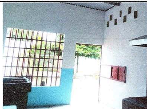
Foto 4: Se observa la finalización de reparación de los muros.
