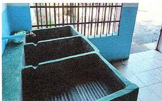
Foto 6: Se observa la finalización de cambio de la pila.
