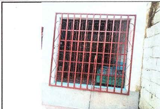
Foto 7 : Se observa la finalización de cambio del balcón de metal.
