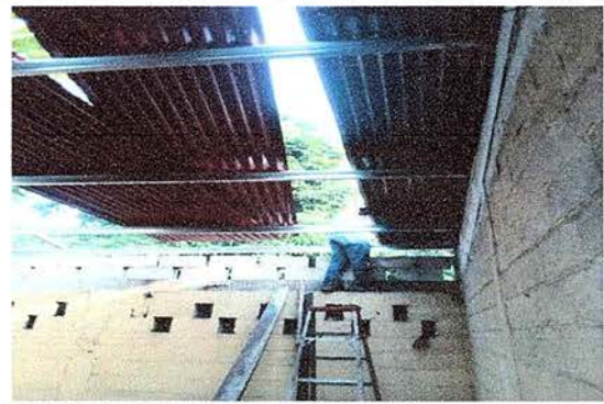
Foto 8 : Se observa el proceso de cambio de la lámina a lámina troquelada calibre 26 aluzinc.
