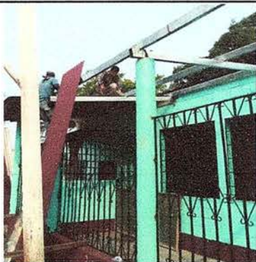
Foto 1: Se observa el proceso de cambio de la lámina.
