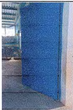
Foto 13: Se observan puertas pintadas y ya hecho el mantenimiento de las mismas
