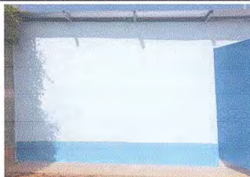
Foto 2: Se observa que las paredes se aplico cernido exterior e interior de la cocina
