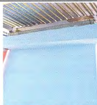
Foto 6: Se observa que el canal ya reparado y funcional.
