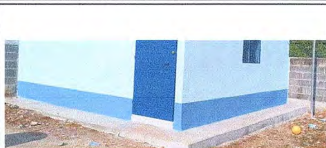
Foto 8: Se observa que se hizo banqueta de concreto en el contorno de la cocina.
