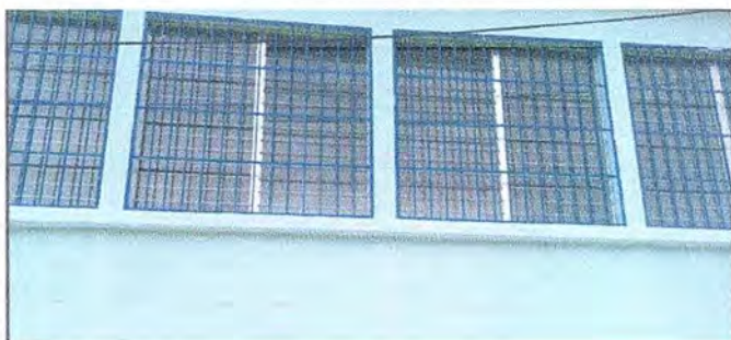
Foto 15: Se observa la instalación finalizada de ventanería de metal mas vidrio en aulas donde ingresaba agua
