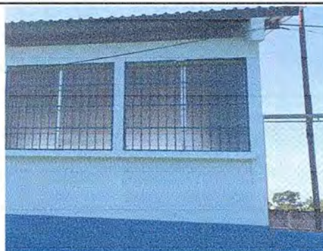
Foto 14: Se observan las paredes de aulas resanadas y pintadas
