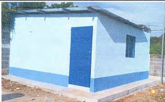
Foto 1: Se observa que la pared está finalizado el repello
