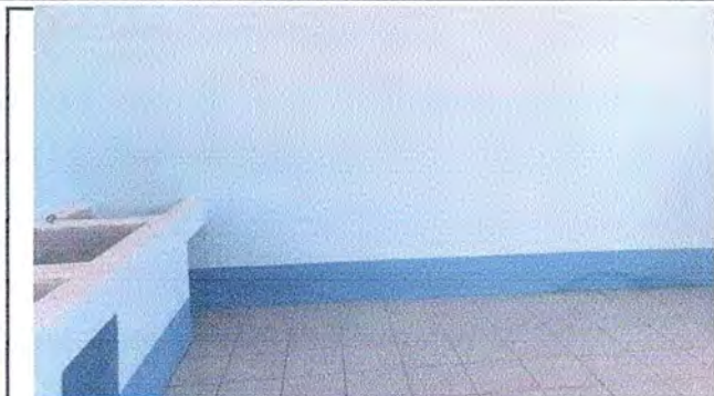
Foto 7: Se observa el piso cerámico terminado.
