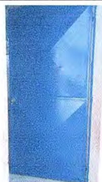
Foto 16: Se observa las puertas ya pintadas con el mantenimiento realizado
