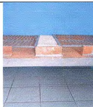
Foto 4: Se observa que la estufa ya reparada y funcional, con el cubrimiento de ladrillo, las parrillas y la chimenea.
