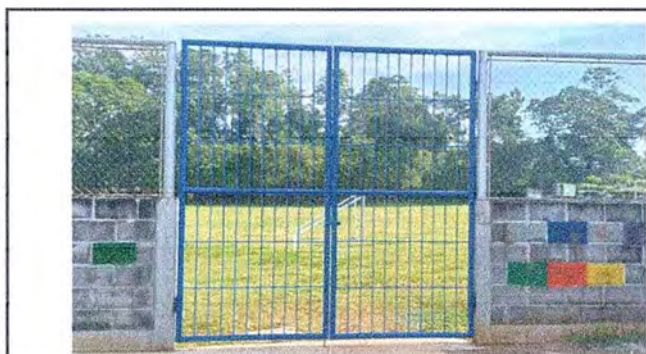
Foto 11: Se observa el portón ya finalizado
