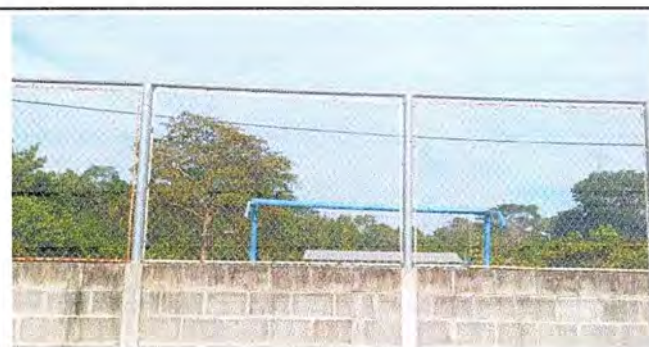
Foto 17: Se observa la malla perimetral ya reparada
