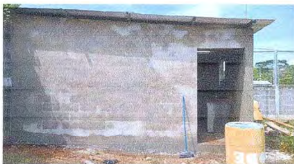
Foto 1: Se observa las paredes proceso de repello
