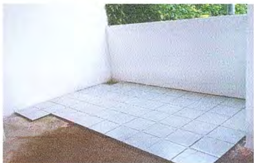
Foto 7: Se observa piso cerámico siendo instalado.
