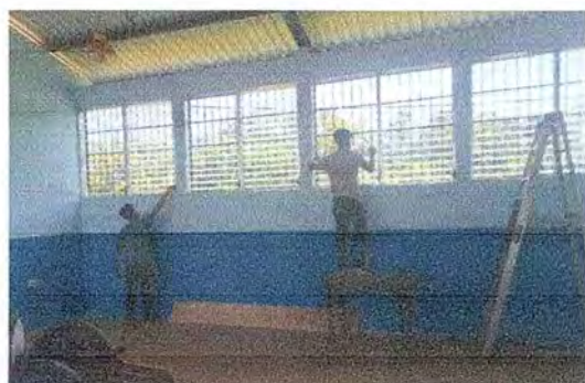
Foto 15: Se observa la instalación de ventanas de metal mas vidrio en las aulas donde se entra agua
