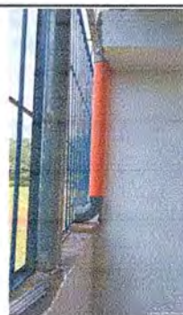
Foto 6: Se observa intalacion canal interior con caída
