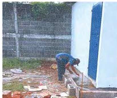
Foto 8: Se observa fundicion manual banqueta de concreto
