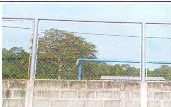
Foto 17: Se observa malla perimetral siendo reparada.
