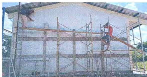
Foto 12: Se observa las paredes siendo repelladas
