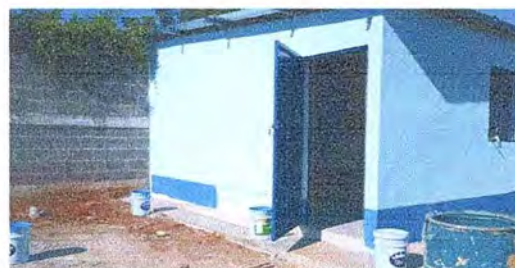
Foto 10: Se observa las paredes siendo pintadas
