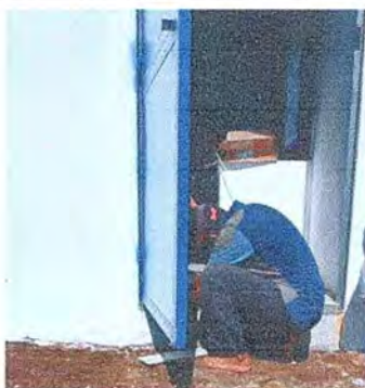
Foto 9: Se observa la puerta siendo instalada
