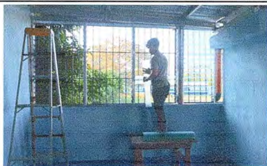
Foto 3: Se observa que las ventanas estan siendo instaladas
