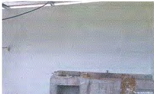
Foto 2: Se observa las paredes proceso cernido
