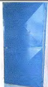
Foto 16: Se observa puerta haciendo el mantenimiento
