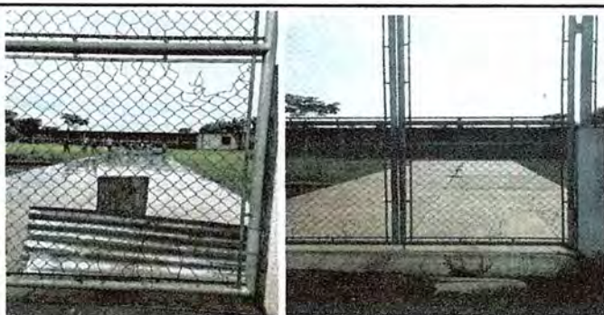
Foto 11: Se observa que el portón tiene dañada la malla
