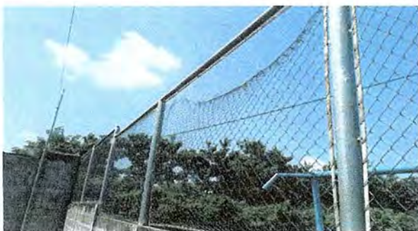
Foto 17: Se observa malla perimetral en mal estado
