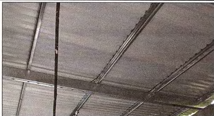
Foto 2: SE OBSERVA EL PROCESO DE LA ESTRUCTURA DE SOPORTE DE METEAL.
