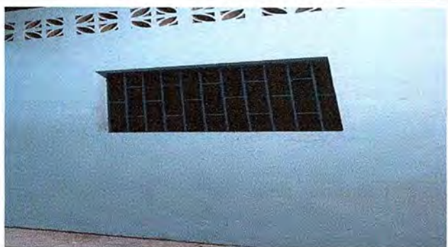
Foto 3: SE OBSERVA COMPLETAMENTE YA INSTALADOS LOS BALCONES.
