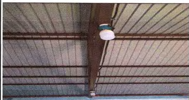
Foto 1: SE OBSERVA TOTALMENTE EL CAMBIO DE LAMINA .
