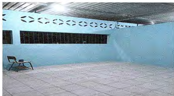
Foto 8: SE OBSERVA YA TERMINADO EL REPELLO
