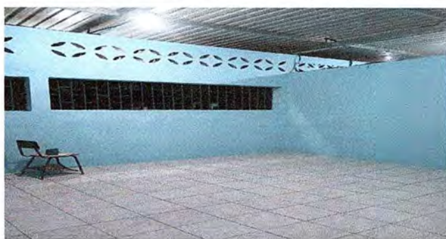
Foto 5: SE OBSERVA EL PISO TOTALMENTE YA INSTALADO.
