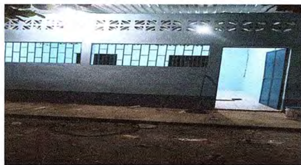
Foto 4: SE OBSERVA LOS BALCONES YA INSTALADOS
