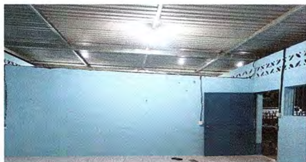
Foto 6: SE OBSERVA EL SISTEMA ELECTRICO YA TERMINADO.
