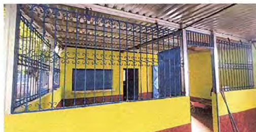
FOTO 2: SE OBSERVA QUE YA FUERON ELEVADAS LAS HILADAS DE BLOCK EN LA PARTE DE ENFRETE DE LA COCINA.
