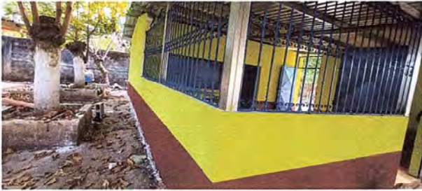
FOTO 7: SE OBSERVA QUE LA PARED DE LA COCINA YA FUERON PINTADAS
