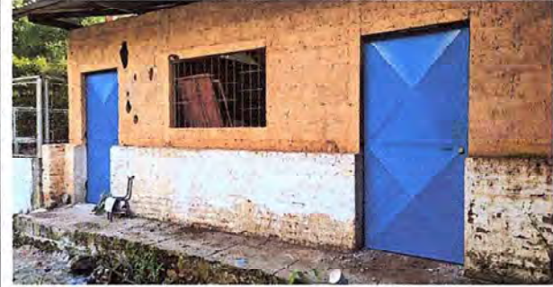
FOTO 10: SE OBSERVA QUE LA PUERTA DE LA BODEGA YA FUE SUSTITUIDA.
