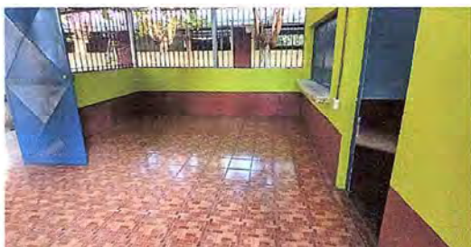
FOTO 1: SE OBSERVA EL PISO CERÁMICO INSTALADO.
