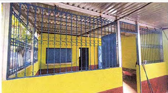
FOTO 3: SE OBSERVA QUE LOS BALCONES YA FUERON INSTALADOS.
