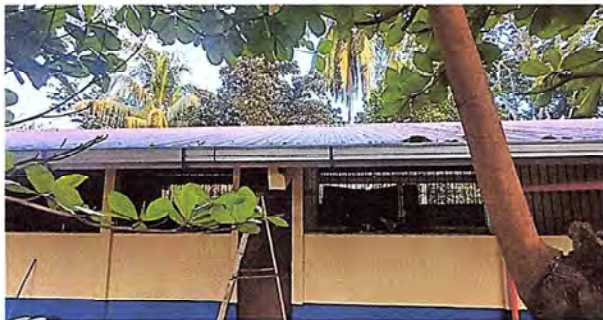
FOTO 9: SE OBSERVA QUE LA LÁMINA DEL MÓDULO 1 YA SE LE APLICÓ PINTURA ANTICORROSIVA.
