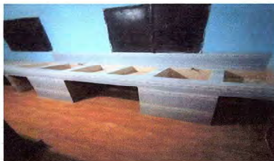
FOTO 4: SE OBSERVA QUE LA PILA YA FUE REPARADA Y SE INSTALÓ AZULEJO.
