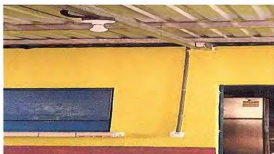
FOTO 5: SE OBSERVA QUE EL CABLEADO ELÉCTRICO YA FUE ENTUBADO.
