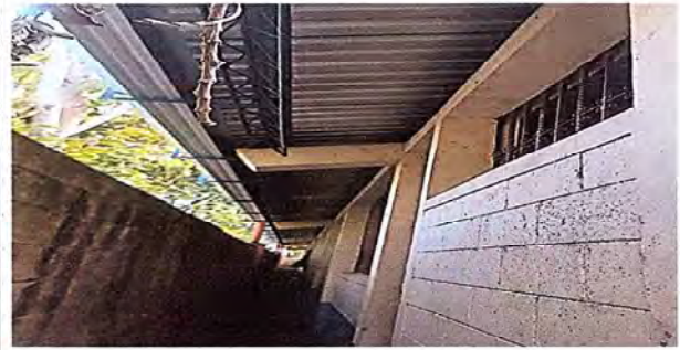
FOTO 8: SE OBSERVA QUE EL CANAL DE AGUA DE LLUVIA Y BAJADA YA FUE CAMBIADO DEL MÓDULO 1.
