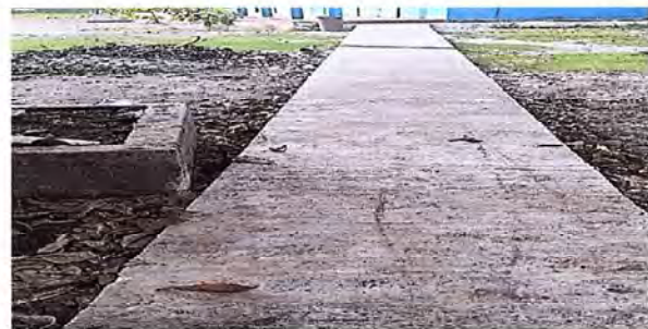
FOTO 11: SE OBSERVA QUE YA SE SUMINISTRO LA PLANCHA DE CONCRETO EN EL PATIO.
