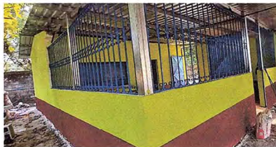
FOTO 6: SE OBSERVA QUE LAS PAREDES DE LA COCINA YA CUENTAN CON REPELO Y CERNIDO.
