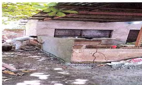
FOTO 2: SE OBSERVA QUE ESTÁN TRABAJANDO EN HILADAS DE BLOCK AL FRENTE DE LA COCINA.
