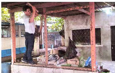
FOTO 3: SE OBSERVA QUE ESTÁN TRABAJANDO EN BALCON DE MALLA.
