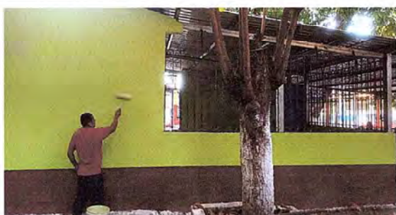
FOTO 7: SE OBSERVA QUE ESTÁN APLICANDO PINTURA EN LAS PAREDES
