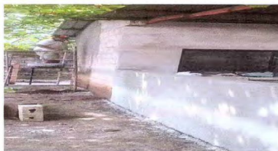
FOTO 6: SE OBSERVA QUE ESTAN TRABAJANDO EN LA COCINA POR REPELLO Y CERNIDO.
