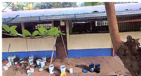
FOTO 9: SE OBSERVA QUE ESTÁN TRABAJANDO EN LÁMINA DEL MÓDULO 1.
