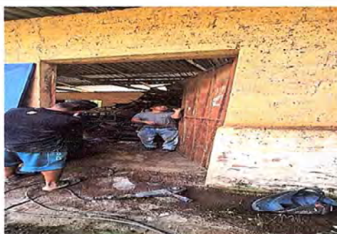
FOTO 10: SE OBSERVA QUE ESTÁN TRABAJANDO EN LAS PUERTAS DE LA BODEGA.
