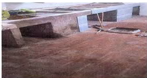
FOTO 1: SE OBSERVA QUE ESTÁN TRABAJANDO EN EL PISO
