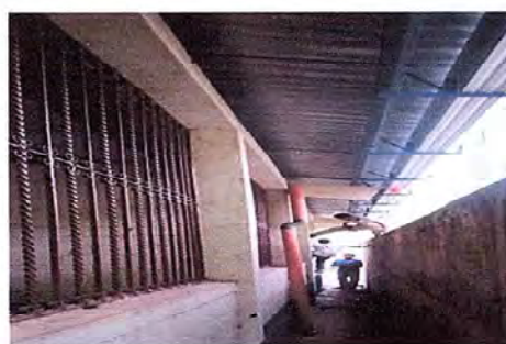
FOTO 8: SE OBSERVA QUE ESTÁN TRABAJANDO EN EL CANAL Y BAJADA DE AGUA.
