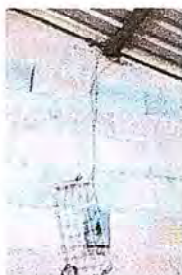
Foto 5: Se observa que el cableado eléctrico se encuentra expuesto en la cocina. Y se necesita entubarlo y cambiar tres luminarias.
