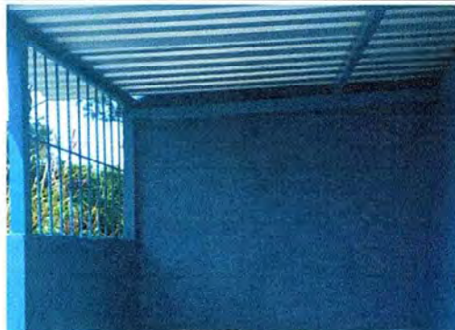
Foto 8: Finalizada la construcción del muro, balcones de metal y cambio de lámina de la cocina
