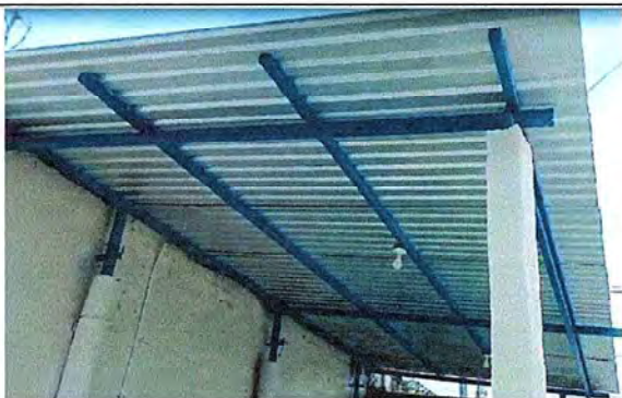
Foto 13: Cambio total de láminas de zinc y estructura portante de metal en el escenario.
