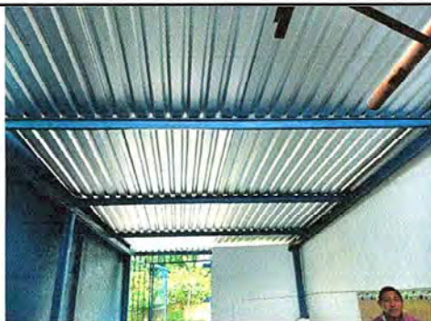
Foto 1: Cumplimiento de la sustitución de lámina de zinc de la cocina.
