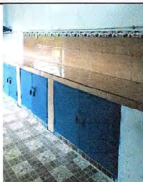
Foto 7: Banco de trabajo finalizado.
