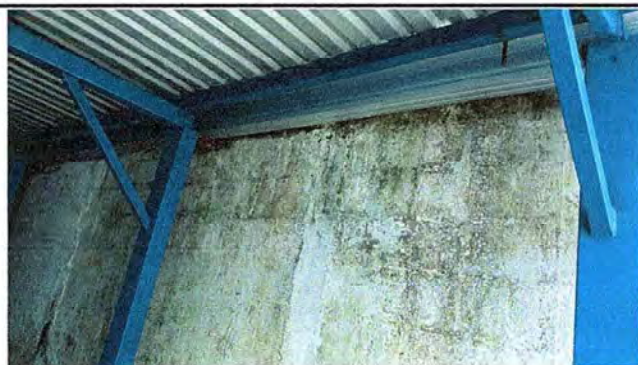
Foto 3: Nuevo canal instalado.
