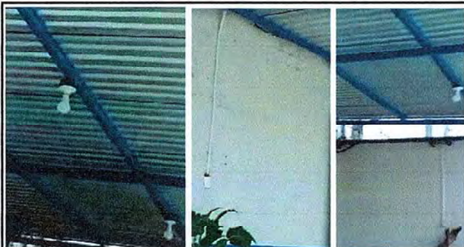
Foto 15: Nueva instalación eléctrica.
