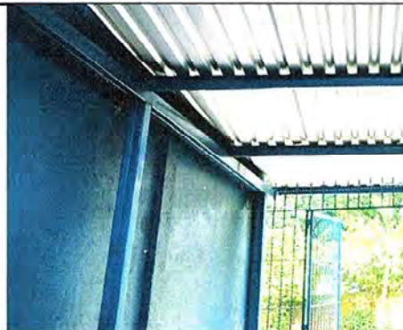
Foto 2: Finalizado la sustitución de la estructura de soporte de metal de la cocina.
