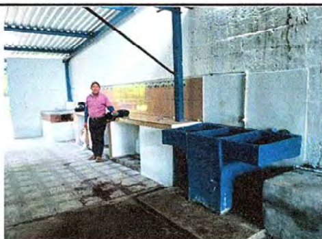
Foto 11: Pila con nueva base terminada.
