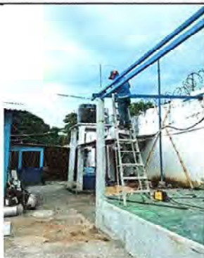
Foto 13: Sustitución de láminas de zinc y estructura portante de metal del escenario.
