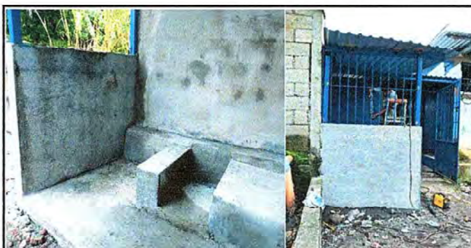
Foto 6: Sustitución de polletón, repello y colocación de balcones.
