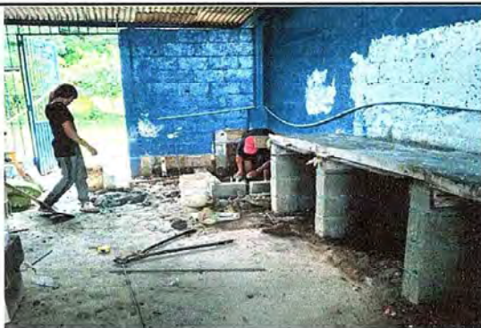
Foto 7: Construcción del banco de trabajo.
