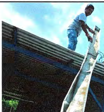
Foto 3: Sustitución del canal por deterioro.
