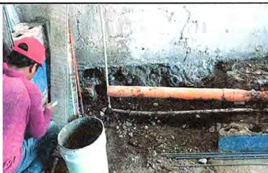
Foto 11: Cambiando la base y el sistema de drenaje de la pila.
