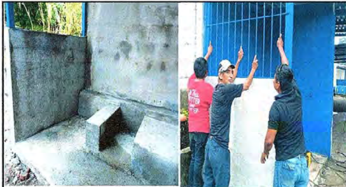
Foto 8: Construcción del muro y balcón de metal.
