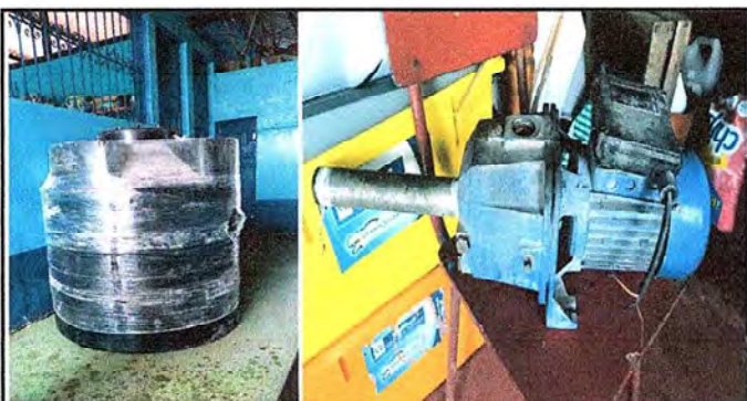
Foto 9: Sustitución de la bomba y depósito de agua por los anteriores.
