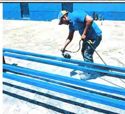
Foto 2: Dando mantenimiento preventivo y correctivo a la estructura de soporte de metal de la cocina.
