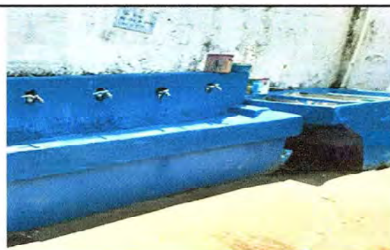
Foto 10: Iniciando el trabajo de sustitución del lavado.
