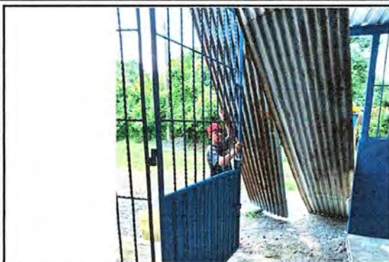
Foto 1: Cambio de láminas de zinc de la cocina, que se encuentran dañadas.
