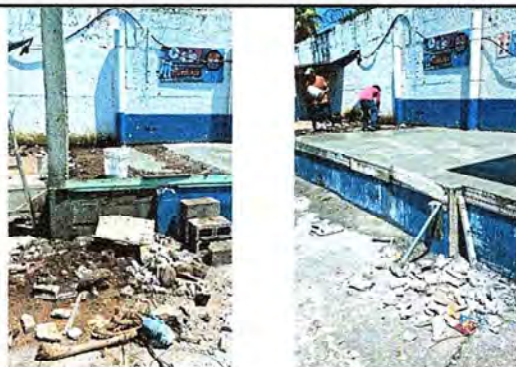
Foto 14: Sustitución de piso, modulo de gradas por deterioro.
