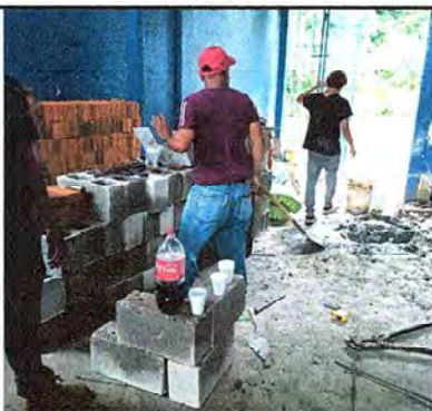
Foto 4: Reconstruyendo el piso de la cocina por encontrarse en mal estado.
