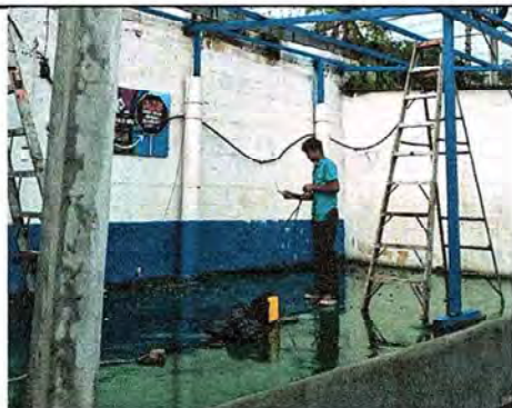
Foto 15: Sustitución del Sistema eléctrico, conectores, plafoneras y lámparas.
