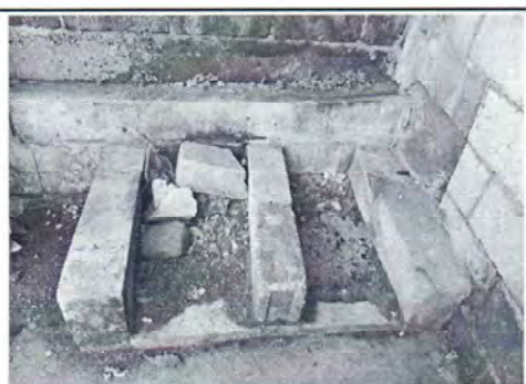
Foto 6: Se observa que también se utiliza un polletón para la cocción del atol, urge sustituirlo por una estufa rural funcional. También es necesario resanar y aplicar repello + cernido.
