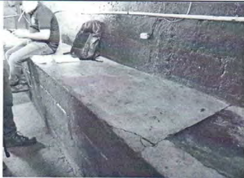
Foto 7: Se observa que el banco de trabajo existente no cumple su cometido, urge sustituirlo. Además es necesario proteger el muro con azulejo
