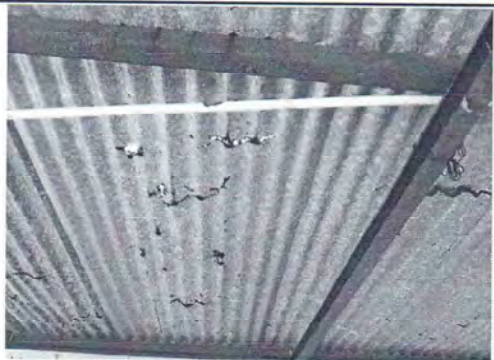
Foto 13: Se observa que la lámina de zinc y estructura portante de metal del escenario se encuentra en mal estado, urge su sustitución
