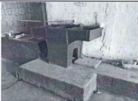
Foto 11: Se observa que la ubicación de la pila no es funcional, es necesario modificar la base y sistema de drenaje
