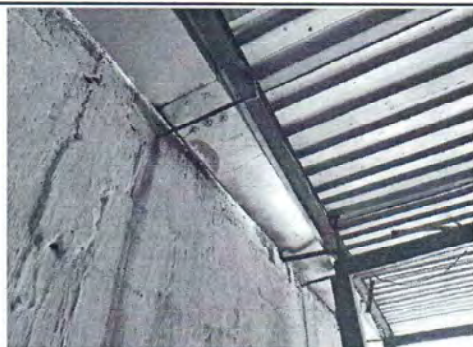
Foto 3: Se observa que canal de metal existente, ya no funciona correctamente, urge su sustitución
