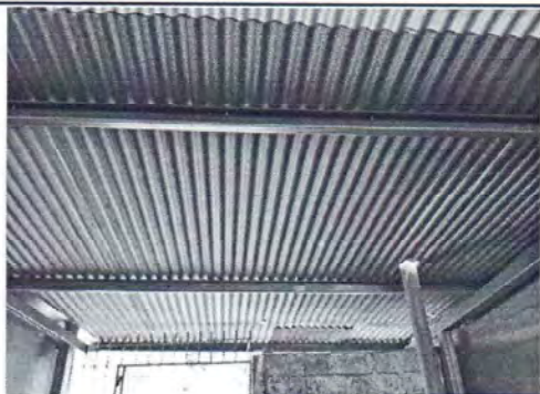
Foto 1: Se observa que lámina de zinc de la cocina, se encuentra dañada por el humo de la estufa rural existente
