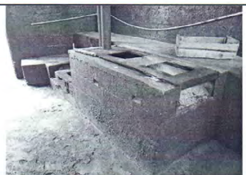
Foto 5: Se observa que la estufa rural existente no es funcional y obstruye, es necesario su sustitución. Asimismo es necesario resanar los muros y aplicar pintura.
