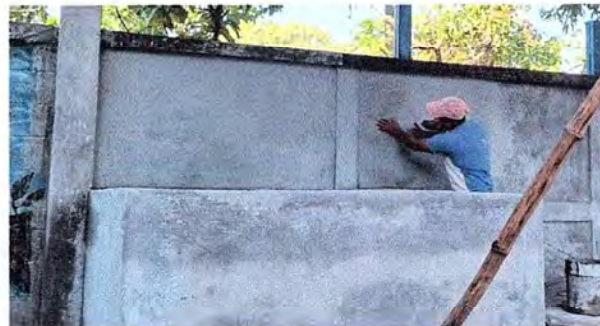
Foto 2: Se observa el proceso de los trabajos de humedad en el muro y repello.
