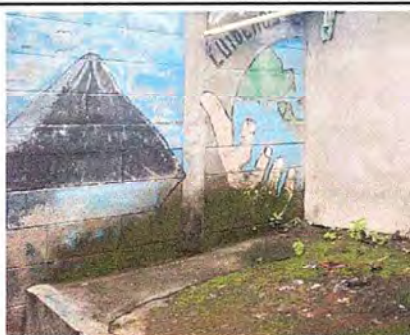
Foto 2: Se observa humedad en el muro y que no cuenta con repello.
