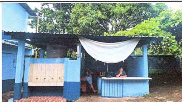
Foto 1: Se observa la carencia de puerta.
