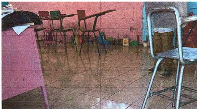
Foto 4: Se observa el piso cerámico ya instalado en las aulas.
