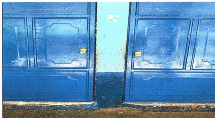
Foto 3: Se observa las chaps ya instaladas.
