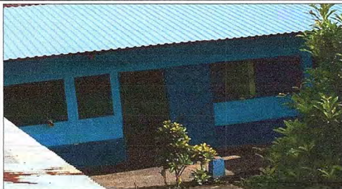
Foto 1: Se observa la instalación de lámina troquelada terminado.
