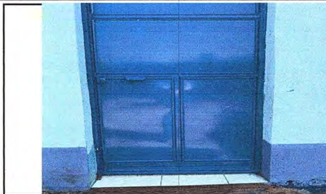
Foto 2: Se observa el mantenimiento de las puertas de las aulas terminado.
