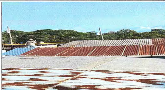
Foto 1: Se observa el proceso de instalación de lámina troquelada.
