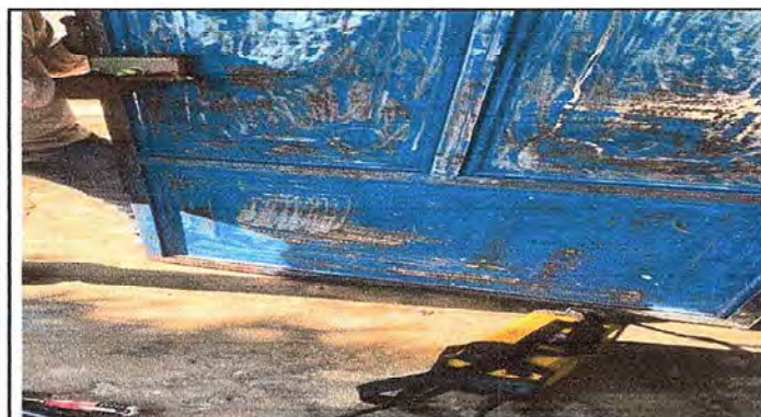
Foto 3: Se observa los procesos de sustitución de chapas.
