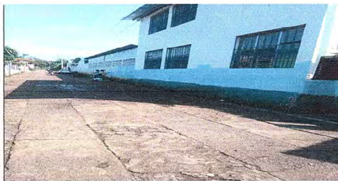
Foto 5: Se observa los procesos de resane y aplicación de pintura en los muros interiores y exteriores.
