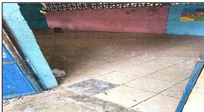
Foto 4: Se observa el proceso de instalación de piso cerámico en las aulas que se encuentra en mal estado.
