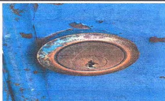
Foto 3: Se observa que las aulas necesitan sustitución de chapas.
