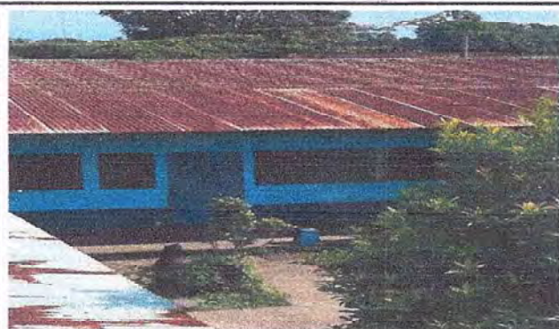
Foto 1: Se observa que la lámina de zinc, se encuentra en mal estado.
