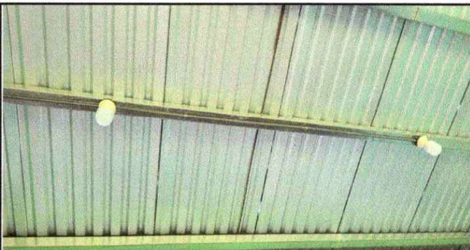
Foto 4: La reparación de las unidades eléctricas finalizadas.
