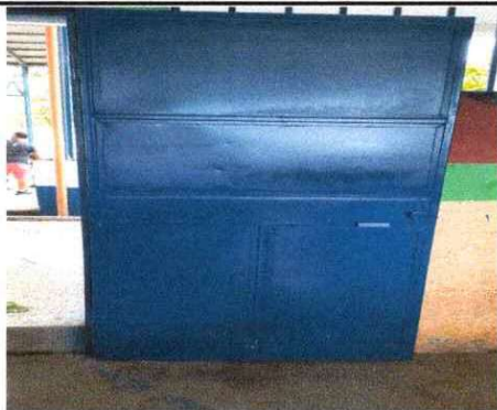
Foto1: Instalación terminada de puertas nuevas a las aulas.
