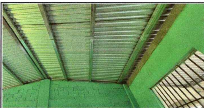
Foto 5: Estructura y enlaminado de las dos aulas finalizada.
