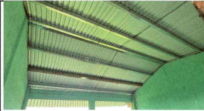
Foto 2: Sustitución de láminas de las dos aulas ya finalizada.
