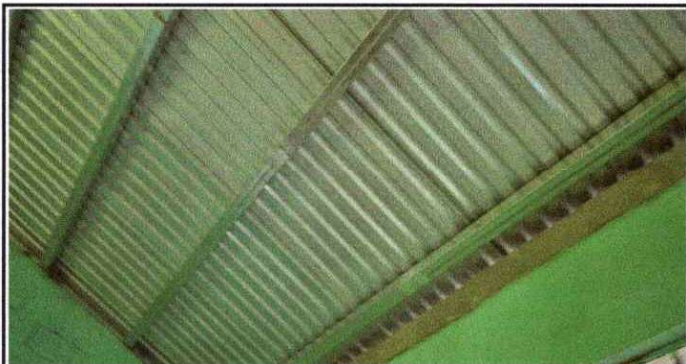
Foto 3: Instalación de estructura para techo de las dos aulas ya terminada.
