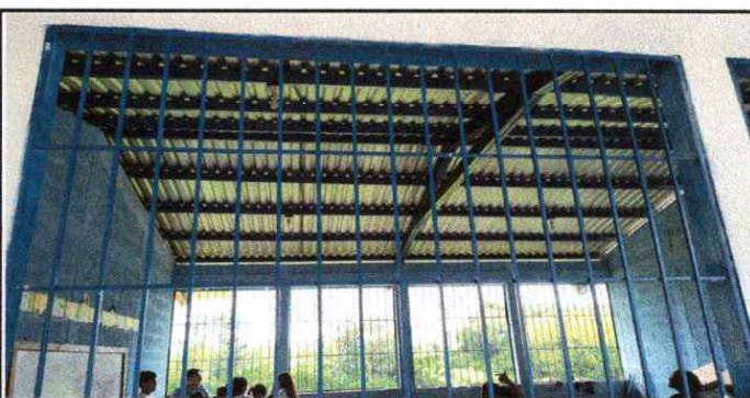
Foto 6: Finalizada la reparación de los balcones.
