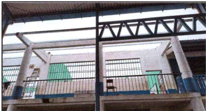
Foto 3: Instalación de estructura para techo de las dos aulas
