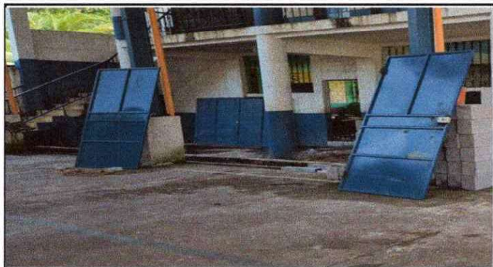
Foto1: Instalando puertas nuevas a las aulas.
