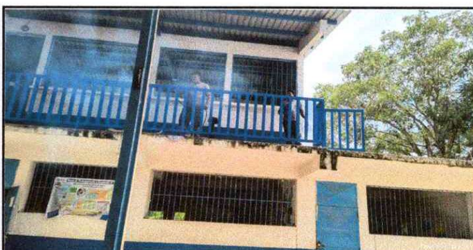
Foto 6: Reparando los balcones y barandales.
