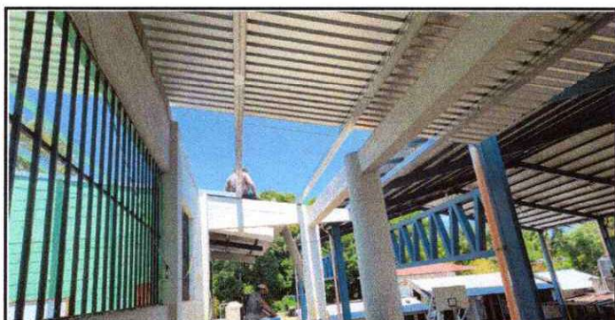
Foto 5: Estructura y enlaminado en proceso.
