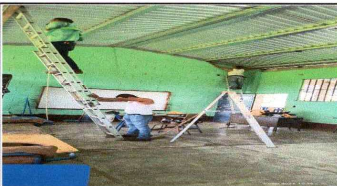
Foto 4: En proceso la reparación de las unidades eléctricas.
