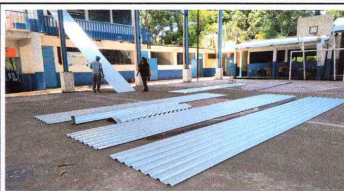
Foto 2: Sustituyendo láminas de las dos aulas.
