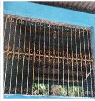
Foto 2: SE OBSERVA QUE EL BALCON DE METAL ESTA EN MAL ESTADO POR LO QUE ES IMPORTANTE LA SUSTITUCION.
