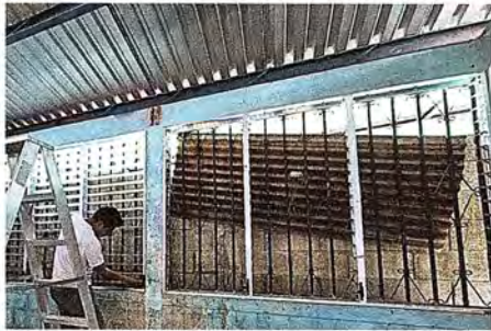
Foto 3: Se observa proceso de instalación de ventanas
