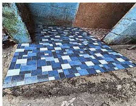
Foto 10: Se observa nivelación e instalación de piso en baños
