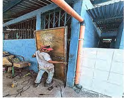
Foto 2: Se observa puerta nueva en proceso de calzado
