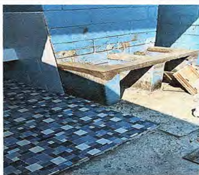
Foto 9: Lavamanos retirados para cambio.
