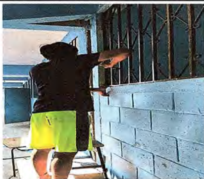
Foto 7: se observa proceso de mantenimiento de balcones
