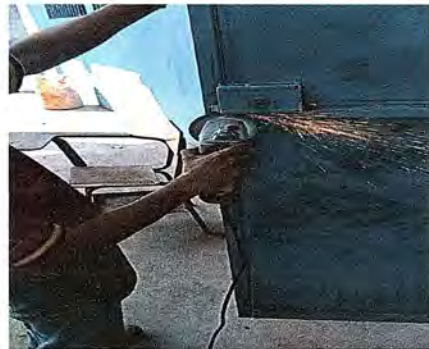
Foto 4: se observa proceso de retiro de chapa dañada
