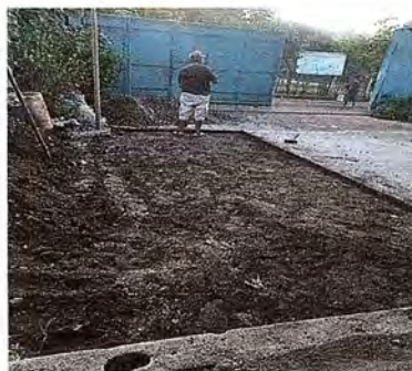
Foto 11: Se observa proceso de reparación de losa de concreto en patio
