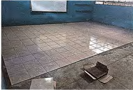
Foto 1: Se observa una fase piso nuevo instalado
