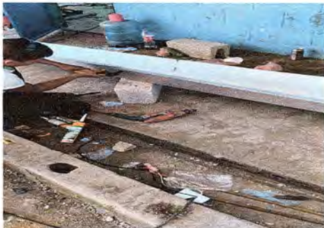
Foto 5: Se observa canal nuevo en proceso de armado
