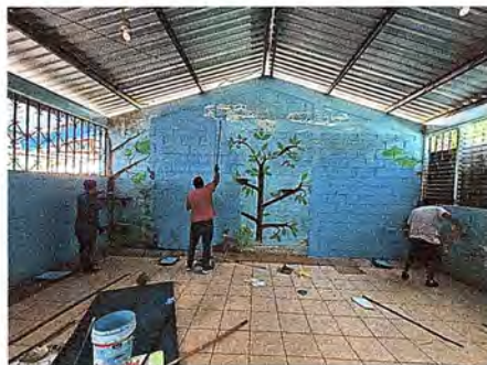
Foto 8: se observa pintado de paredes
