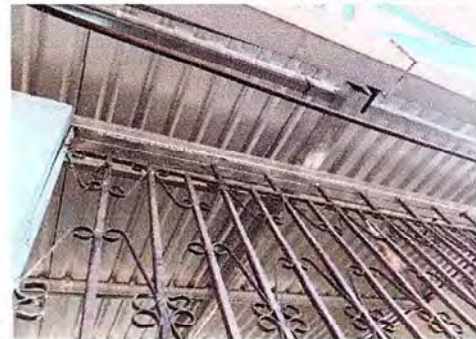
Foto 8: Se observa estructura de soporte nueva
