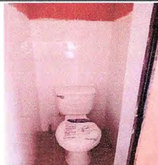
Foto 4: se observan paredes con azulejo nuevo
