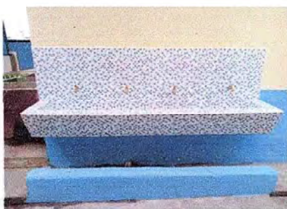
Foto 5: Se observa lavamanos de concreto totalmente reparado, azulejo nuevo, chorros nuevos
