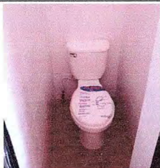
Foto 3: Se observan inodoros nuevos, con accesorios y sin problemas con el funcionamiento
