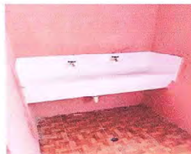
Foto 6: Se observa lavamanos en área de baño de niñas totalmente reparado, azulejo nuevo y paredes pintadas
