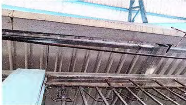
Foto 7: Se observa lámina totalmente nueva
