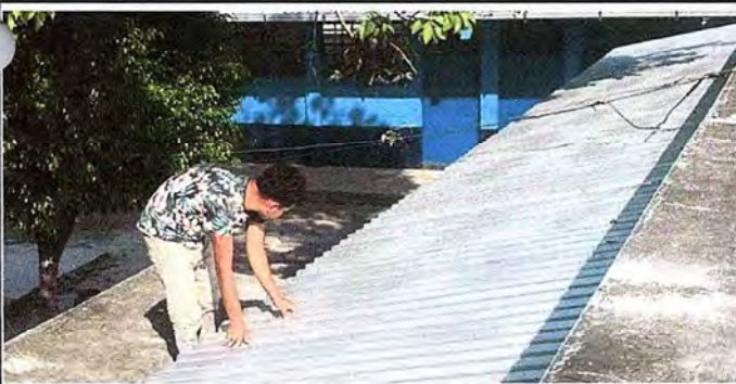
Foto 5: Se observa el proceso de cambio de lámina en los ventanales del salón de usos múltiples.
