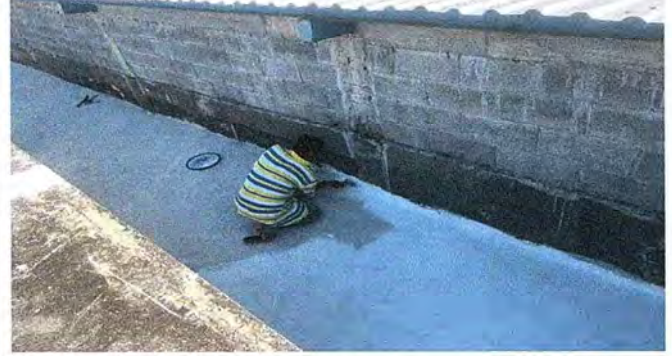
Foto 2: Se observa el proceso de trabajo de impermeabilización de losa en la parte de arriba del salón de usos múltiples.
