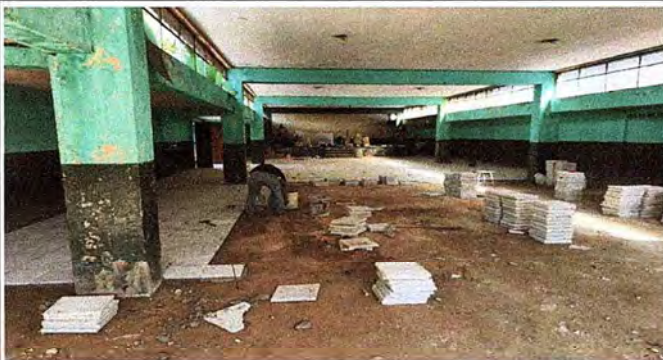
Foto 3: Se observa el proceso de sustitución de piso en el salón de usos múltiples.
