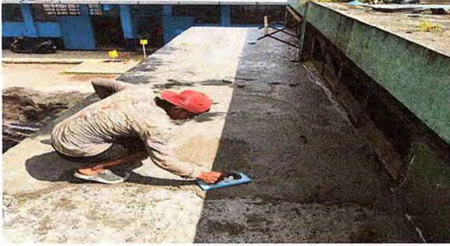
Foto 1: Se observa el proceso del trabajo de los pañuelos en la parte de arriba del salón de usos múltiples.
