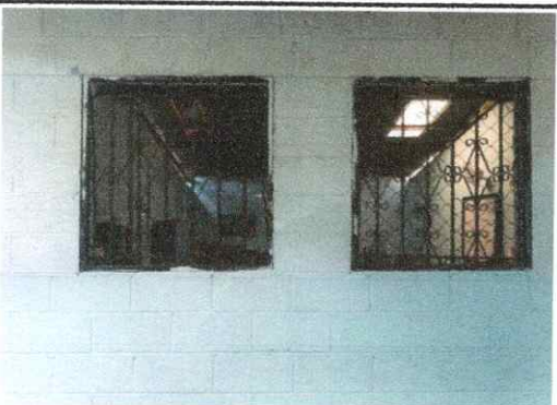
Foto 3: Se observan ventanas del módulo 1, se necesita ampliación para mayor fluidez de aire.
