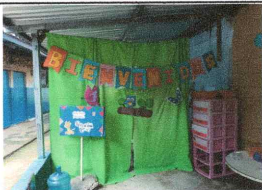
Foto 7: Se observa la división de dos aulas, será reemplazada por entrapaño de metal y plywood en el módulo 3.
