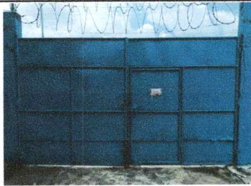
Foto 8: Se observan daños de óxido y picaduras en gran parte de la estructura del portón.
