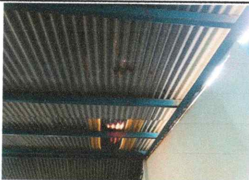
Foto 1: Se observa deterioro por óxido y picaduras en láminas del módulo 1.
