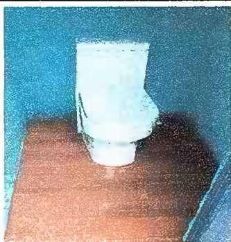
Foto 5: Módulo 2: Instalación de inodoro
