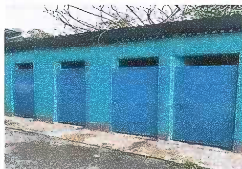
Foto 4: Módulo 2: Mantenimiento a estructura de puerta (lijado, cambio de tubo, cepillado, sujeciones, aplicación de pintura) a puertas servicios sanitarios
