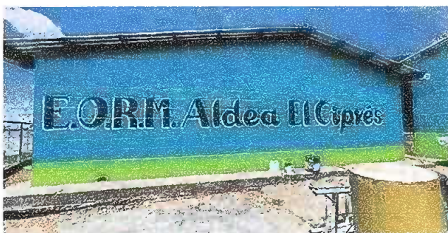
Foto 3: Módulo 1: Pintura en muros exteriores e interiores
