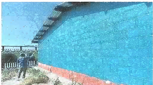
Foto 3: Modulo 1: Pintura en muros exteriores e interiores
