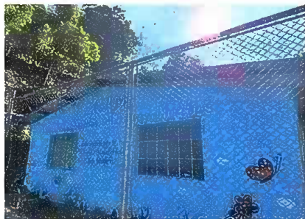
Modulo 1: Pintura en muros exteriores e interiores
