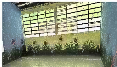
Modulo 1: Pintura en muros exteriores e interiores
