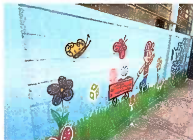
Modulo 1: Pintura en muros exteriores e interiores
