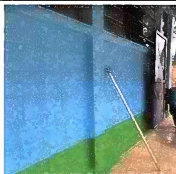
Modulo 1: Pintura en muros exteriores e interiores
