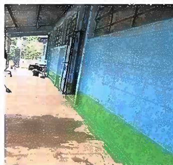
Modulo 1: Pintura en muros exteriores e interiores
