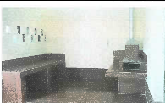
Foto 8: Módulo 3: Sustitución de estufa rural (completa) incluye chimenea y plancha de metal
